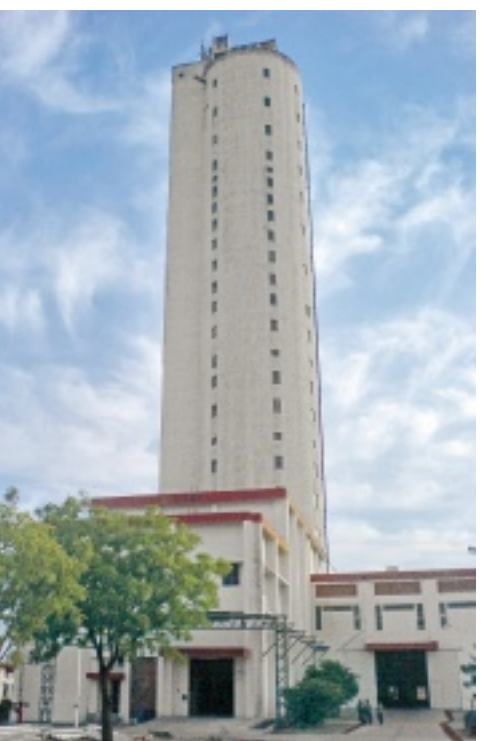
Vertikale Linien zur Produktion von Hochspannungskabeln vertical lines for the production of high-voltage cables
